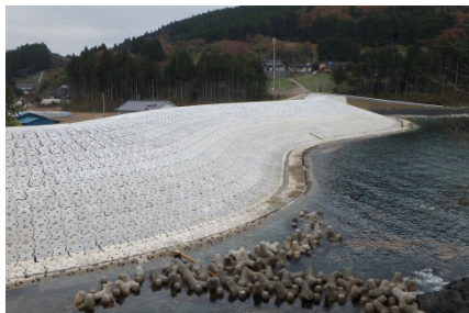
宮城県気仙沼市唐桑町の荒谷前海岸。かつて浜があった場所にT.P.約11m、幅(厚さ)約60mの緩傾護岸がつくられた。(2015年11月)
