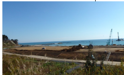
宮城県気仙沼市本吉町の小泉海岸。震災後に生じた塩水湿地や砂浜を埋め、T.P.14.7mの防潮堤建設が進んでいる。(2015年11月)
