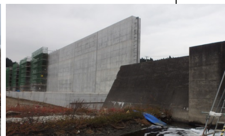
岩手県陸前高田市長部漁港。震災前はT.P.6.5mだった防潮堤は、12.5mとなる。(2015年11月)
