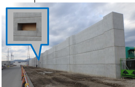
宮城県気仙沼市朝日町。海が見えないという住民の訴えを受け、窓を開けたという。窓にはアクリル板がはめられる予定。(2015年11月)
