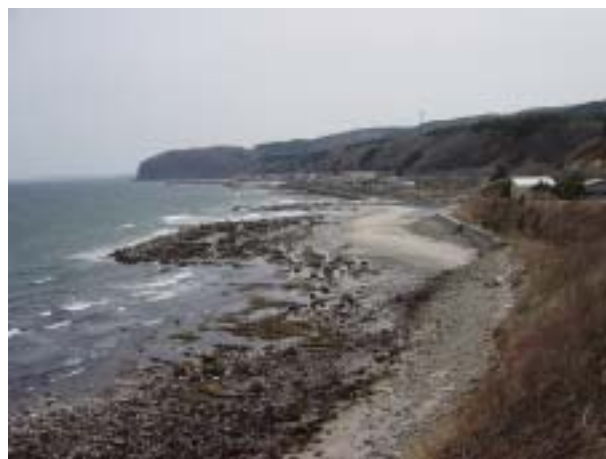
写真 - 5 現在の木野部海岸。懇談会の結果、住民から提案され実施された構造物。伝統工法の築磯に似て、消波機能も有している
