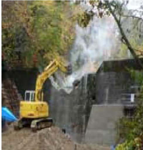
図4. 防災と溪流環境復元のため、治山ダムの中央部撤去の様子（平成21年10月実施）
